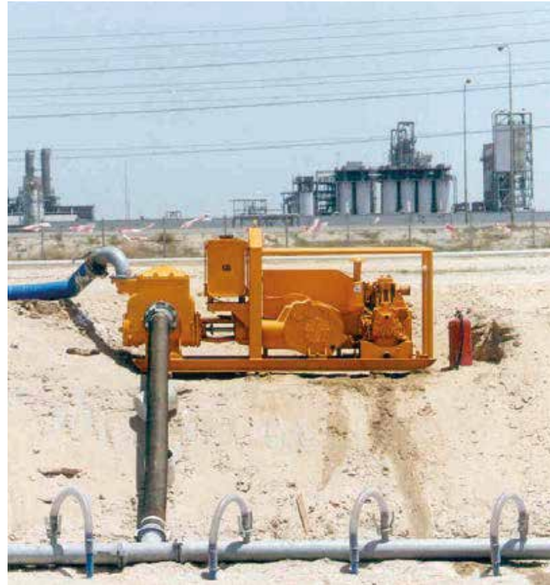
Well point dewatering Rabattement de nappes par pointes filtrantes
