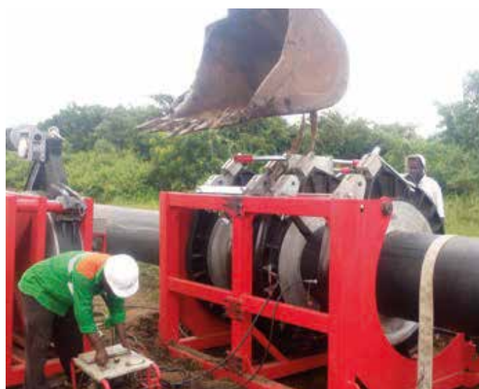
Polyethylene pipe butt welding Soudage bout à bout de tuyaux en PE
